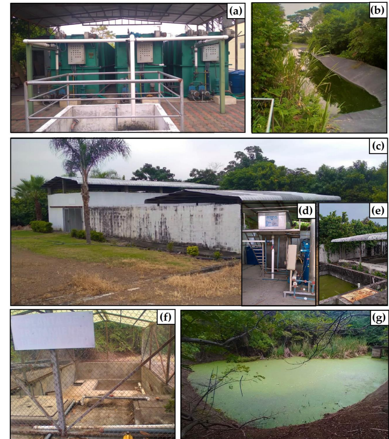
Figura 1. Sistemas depuradores existentes en el campus.
