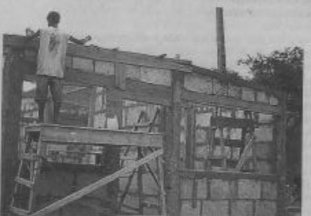
Un obrero trabaja en la edificación de la villa modelo, cuyo lanzamiento se realizará a fines de mes.
