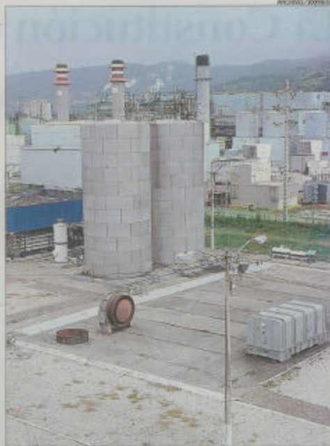
Electroecuador (generadora de energía) es garante hipotecario en obligaciones a terceros a favor del Banco del Progreso.
